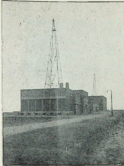
Zendgebouw en antenne-torens van den Phonizender te Huizen.
